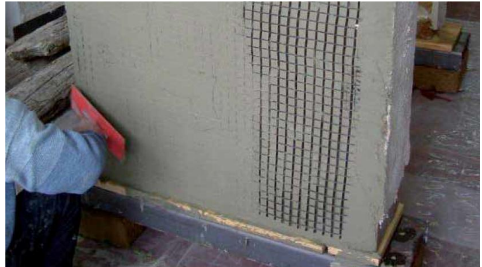
Realizzazione del campione rinforzato con PLANITOP HDM MAXI e MAPEGRID G220
